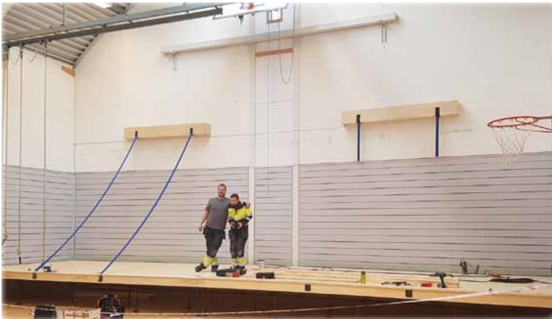
Bjarte Hustrulid og Ørjan Litland fra KIS VEST AS monterer heve-/senkescene med ribbevegger hos kunde i Bergen.
