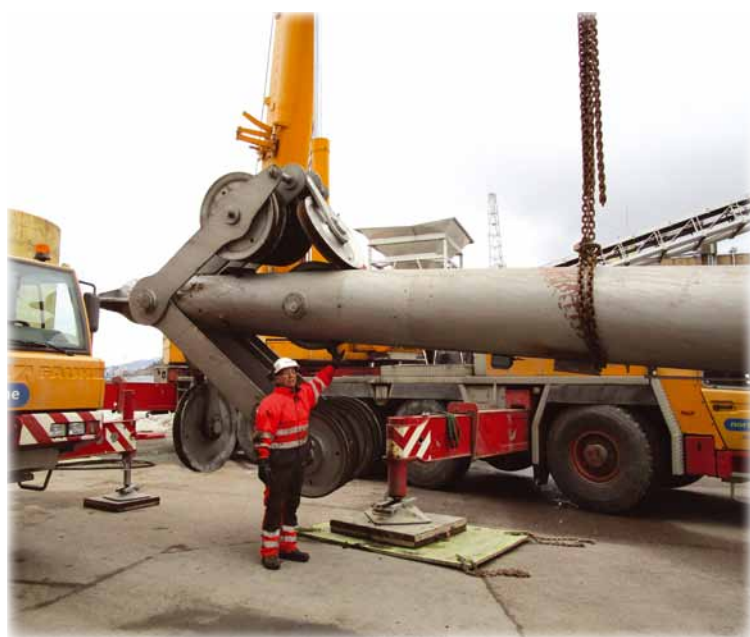
KIS ØST AS i full gang med demontering og flytting av tungløftkranen "Stubbebryteren" på Sjursøya.
